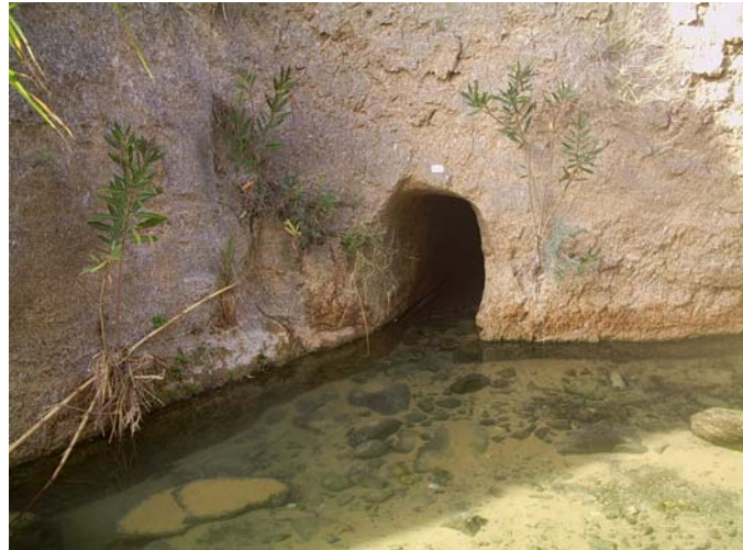
Galerías para captar el agua (Punto 2 de la fig. 11) (Jorge Jiménez Sánchez)
