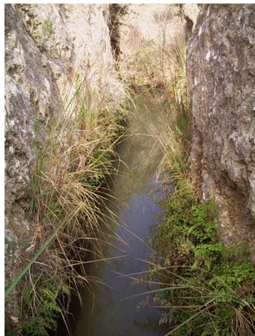
Acequia paralela al cauce (Punto 6 de la fig. 11) (Jorge Jiménez Sánchez)
