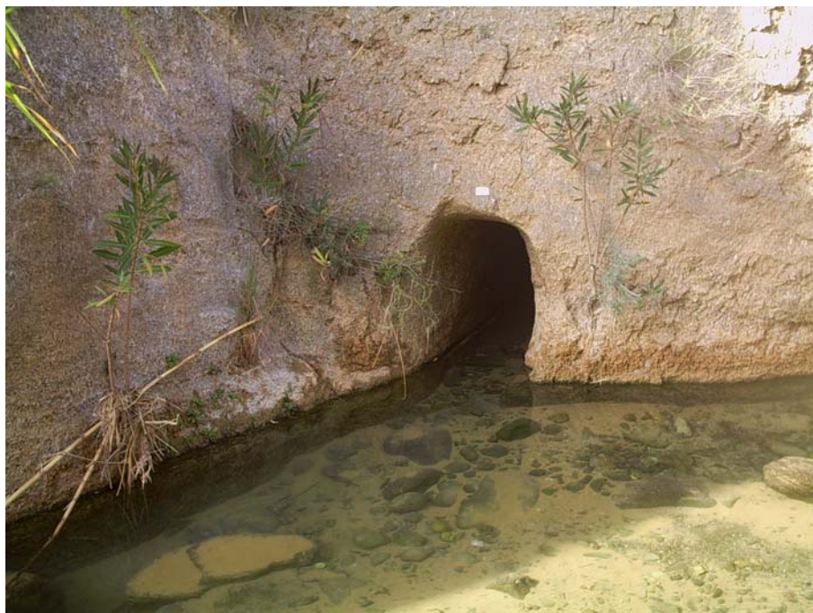
Galería realizada para la captación del agua del acuífero y la perteneciente a crecidas del río (Jorge Jiménez Sánchez)
